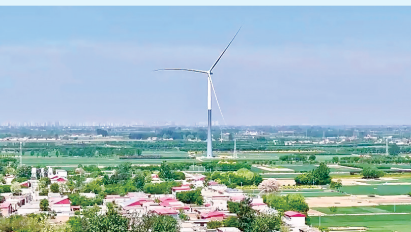
定州市集中式风力发电项目(一期五十兆瓦)。
