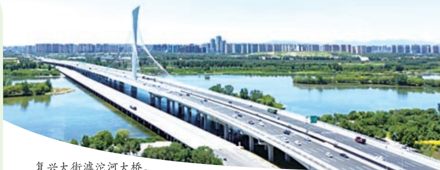
复兴大街滹沱河大桥。
