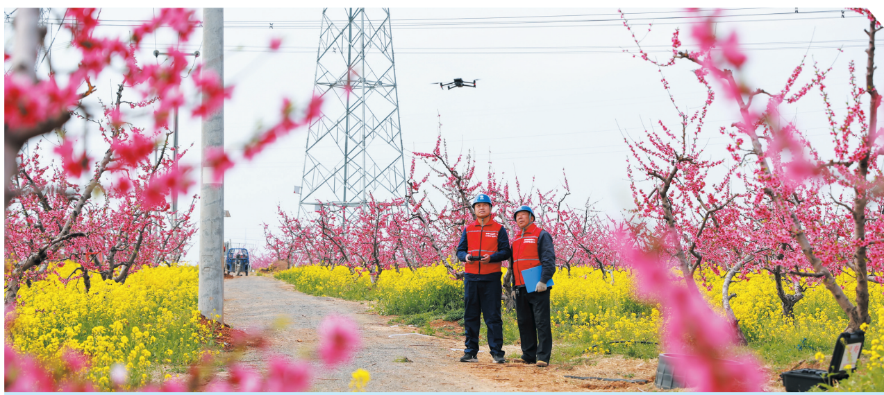
春季气温回升、少雨多风,森林火灾隐患持续攀升。为确保电网安全运行,灵寿供电公司及时启动防火专项巡视行动,精准确定重点防控区域,组建特巡小组,采用“无人机+人工”协同模式,对五岳寨线、漫山线等11条穿越林区线路进行精细化巡视,保障电网安全稳定运行。 尹冀娜 高颖 摄
