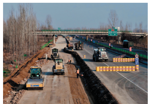
近日,张石公司G95改扩建项目抢抓气温回升有利时机,持续优化施工组织,强化施工管控和要素保障,全力攻坚施工节点任务。姚睿馨 张书学 摄
