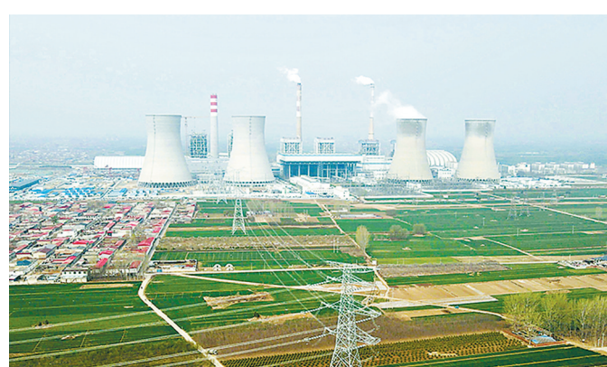
四月一日，由国网河北建设公司建设管理的定州电厂三期500千伏送出工程建成投运。米哈 摄
