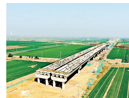
国道G515无极县绕城段施工现场。
