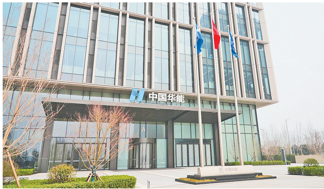
位于雄安新区启动区的中国华能集团有限公司总部大楼。 本报记者 马宁 李相伯 摄
