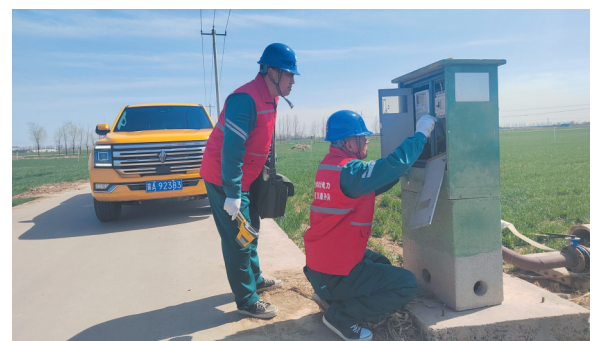
3月18日,赵县供电公司员工到赵县赵州镇对高标准农田机井用电设备进行全面检查,保障春季农业排灌安全用电。 高云峰 侯西果 摄
