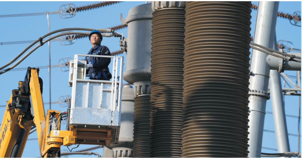
近日,廊坊电网春检预试工作全面启动。图为3月18日廊坊供电公司工作人员对固安500千伏变电站断路器开展回路电阻、绝缘等进行等试验,同时对500千伏隔离开关、电流互感器进行维护。这是该公司首次开展500千伏级修试工作,标志着廊坊电网超高压设备运维检修能力实现新突破。 李刚 摄
