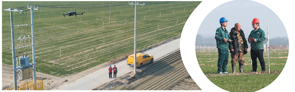
无极供电公司员工开展无人机专项巡检,全力保障春灌用电安全无忧。 全云涛 摄
