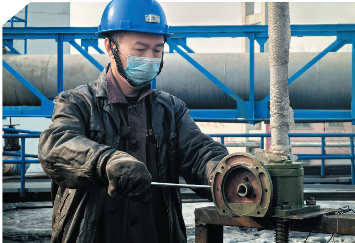
近日,冀中能源峰峰集团邯郸洗选厂对浓缩机进行改造,加装自动间板增加储水功能,实现生产启停期间水平衡,全系统开停车时间控制在10分钟以内。图为该厂机电维修车间职工安装调试阀门。高聪 摄
