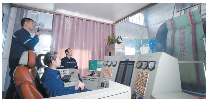
开滦集团钱家营矿业公司聚焦主井提升系统专项检修、安全确认、制度落实等关键环节，以高标准、严要求保障主井提升系统安全可靠运行。图为该公司机电科主井工作人员正在做设备生产运转前的调试工作。刘建强 摄
