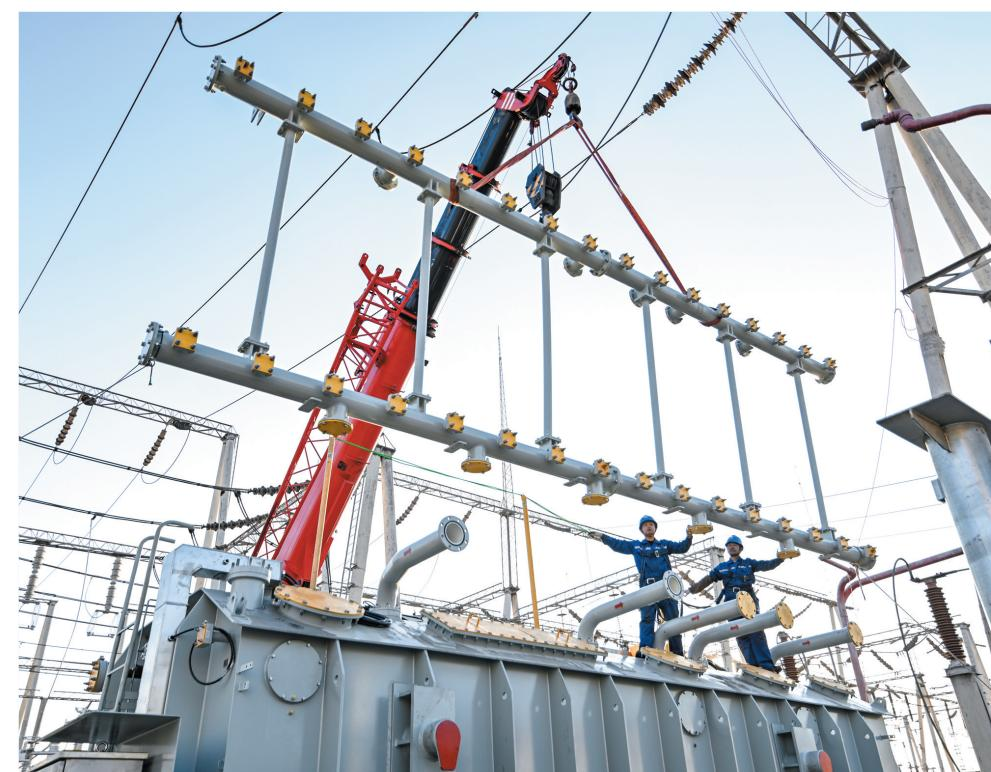
12月20日,石家庄供电公司2025年秋季检修工作全面完成。本次检修以提升设备可靠性为核心,高效推进285项检修任务,并创新应用标准化作业体系与智能装备,显著提升现场安全与效率,为电网迎峰度冬奠定坚实基础。图为该公司变电检修中心员工在220千伏韩通变电站进行变压器组装。
