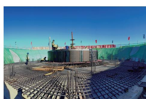
12月4日,在中国石油华北油田任丘15万千瓦风电项目现场,施工人员顺利完成桩基钢筋绑扎作业。该项目是中国石油华北油田首个集中式风电项目,计划于2026年12月底前并网发电。项目采用国际领先的低风速大型风机技术,风电机场每年可提供清洁电能3.2亿千瓦时,可有效推动华北油田实现能源结构转型。
