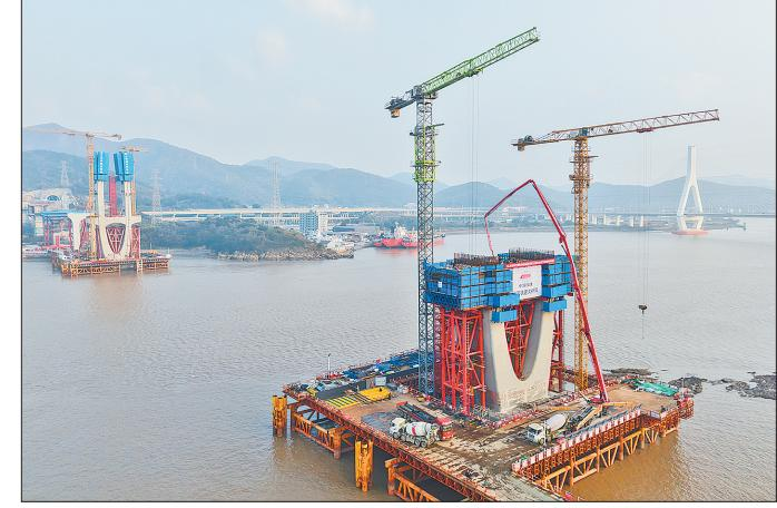
12月1日拍摄的甬舟铁路富翅门公铁两用大桥20号主墩下横梁浇筑现场（无人机照片）。
