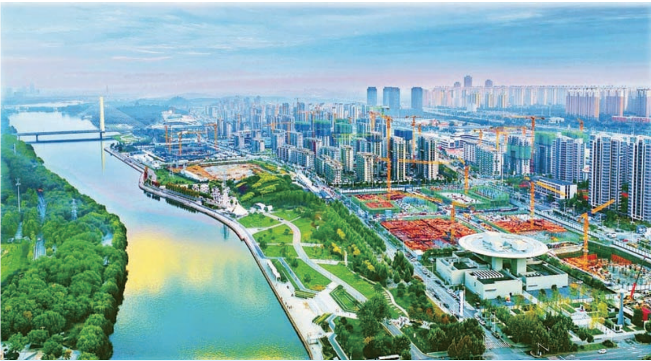
远眺太平河城市片区，碧波如练、楼宇次第，宛如一幅壮美画卷徐徐展开。金秋时节的石家庄，城市建设现场热潮涌动。六大片区、城市地铁、城中村改造、石家庄北站升级改造等重点项目快速推进，勾勒出城市面貌日新月异的生动图景。 董永博 摄
