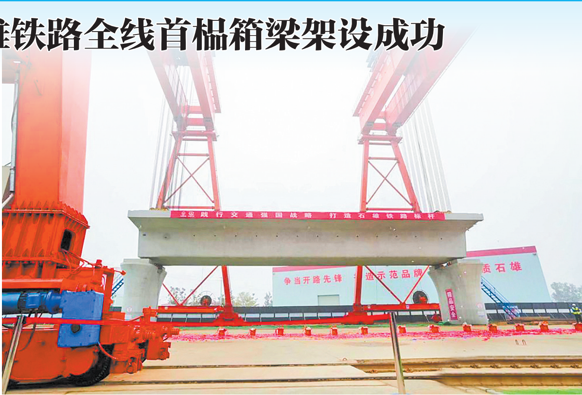
预制箱梁稳稳落于桥墩上。
