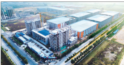
京联科教智慧产业园项目是永清县重点建设项目,项目建成后将加强相关产业链招商合作,构建起完整、高效的图书全产业链服务体系。同时,将升级先进的自动化仓储设备和信息化管理系统,满足图书及相关产品大规模、高效率的仓储物流需求。图为项目建设现场。段永彬 庞趁友 摄
