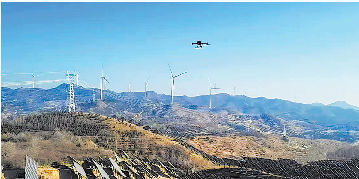
在承德围场滴水湖光伏电站，无人机正在进行智能巡检。
