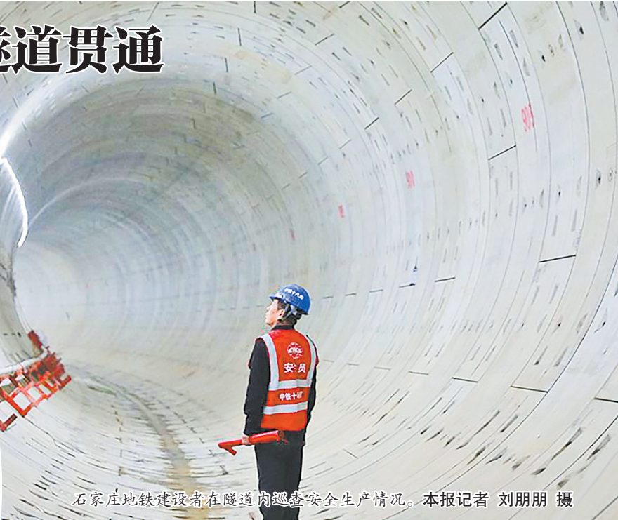
石家庄地铁5号线一期工程红旗桥站—新石北路站区间贯通。
