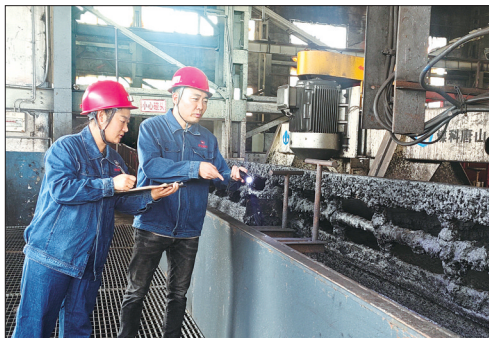
开滦股份吕家屯矿以保证洗煤生产安全高效运行为目标,加密设备巡查频次,严查安全风险隐患,精细调控洗选流程,狠抓精煤回收率,确保圆满完成全年目标任务。图为该矿洗煤厂主洗车间员工巡查浮选机出料情况。张婧 摄
