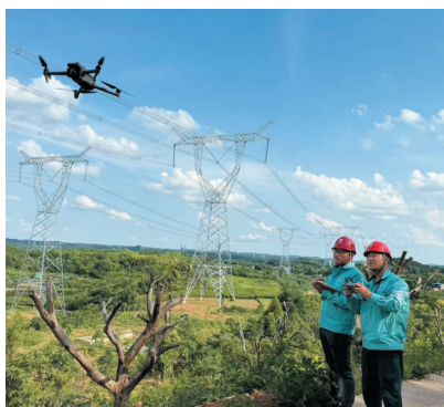
阿坝—成都东1000千伏特高压交流工程线路14标项目应用无人机巡查。
