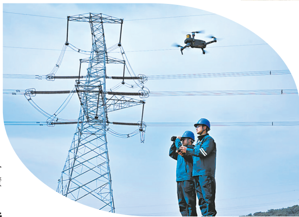
▲秦皇岛供电公司员工利用无人机巡视输电线路。张明煌 摄
