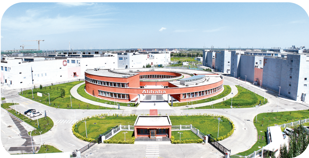
阿里巴巴张北庙滩数据中心园区俯瞰图。
