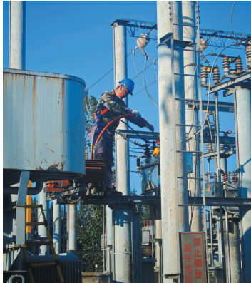
近日,巨鹿县35千伏张王疃变电站绝缘化改造工程顺利完工并投运,显著提升了设备安全运行水平。此举将极大减少线路故障,为区域经济社会发展提供更坚强可靠的电力保障。南丽森 张薄承 摄
