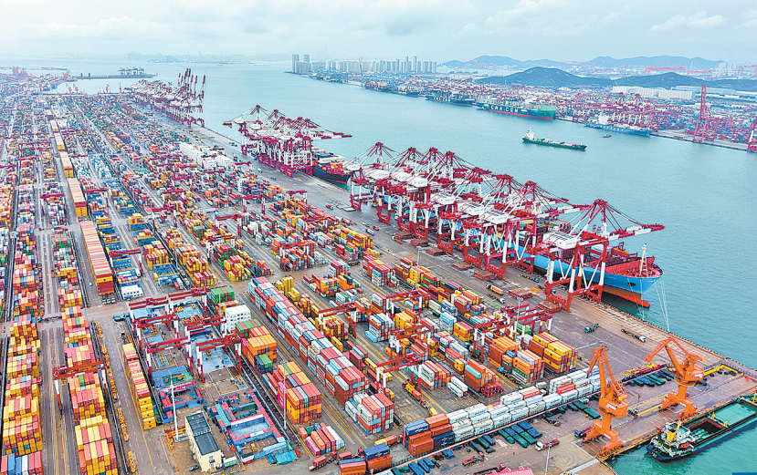
10月13日在山东港口青岛港拍摄的外贸集装箱码头(无人机照片)。
