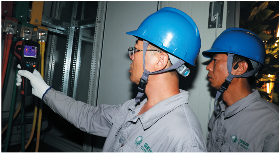
“双节”假期,唐山供电公司通过强化电网运行监测、开展设备特巡特护、优化电网运行方式、组建应急抢修队伍等系列举措,全力筑牢假期保电“防护网”。 桂宝利 摄
