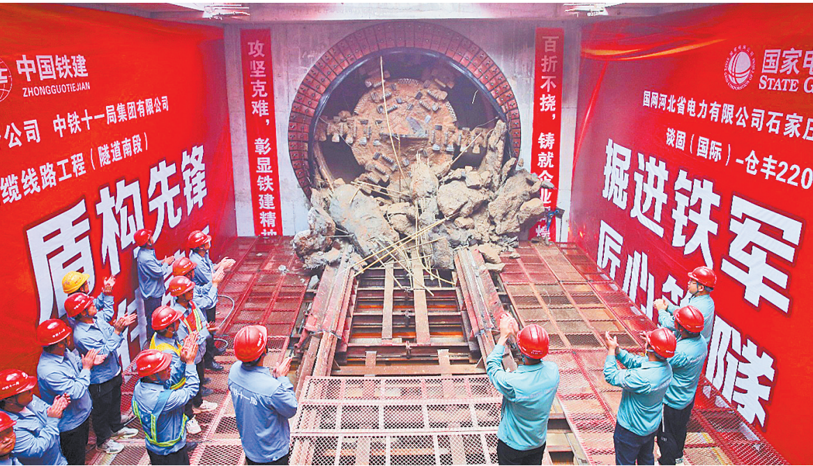
盾构机成功贯通南段电缆隧道6号接收井。
