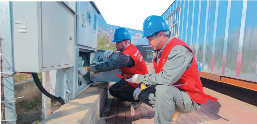
9月17日,国网尚义供电公司大青沟镇供电所人员检修、维护“共享用电”设备。 潘洪峰 摄
