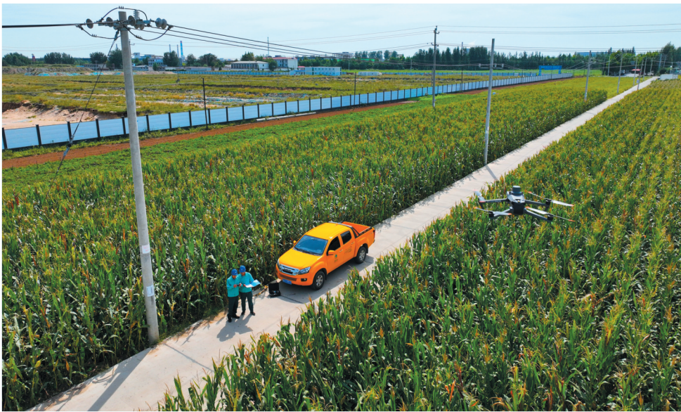
石家庄供电公司把保障粮食生产用电作为头等大事,坚持“农时优先、安全为基、服务前移”原则,实施“三秋”供电服务保障系列举措。图为,国网行唐供电公司员工在安香乡西留营村对10千伏852科技三线开展无人机巡视,保障秋收顺利开展。 陈浩 摄
