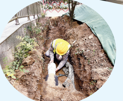
供热企业的工作人员正在对二次管网进行更换。 石家庄市城管局供图
