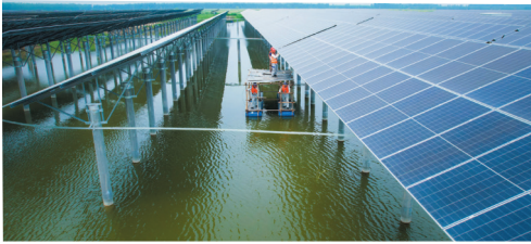
唐山供电公司党员服务队到玉田县石臼窝镇35千伏泰合韵瑶光伏电站巡视光伏板。 周宇翔 摄
