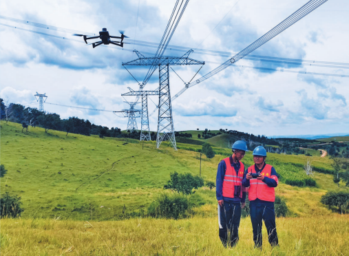
9月10日,国网供电公司员工在卡伦后沟牧场对±800千伏特高压直流输电线路进行巡护。据了解,该公司负责500千伏及以上线路共7条、241.6公里属地化巡护工作,保障新能源外送通道正常运行。 刘春学 摄
