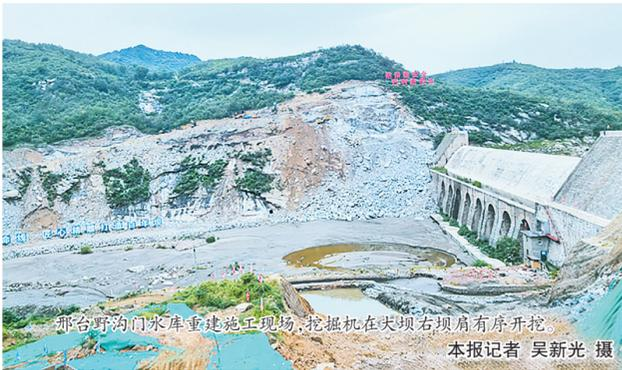
邢台野沟门水库重建施工现场,挖掘机在坝肩坝顶有序开挖。本报记者 吴新光 摄
