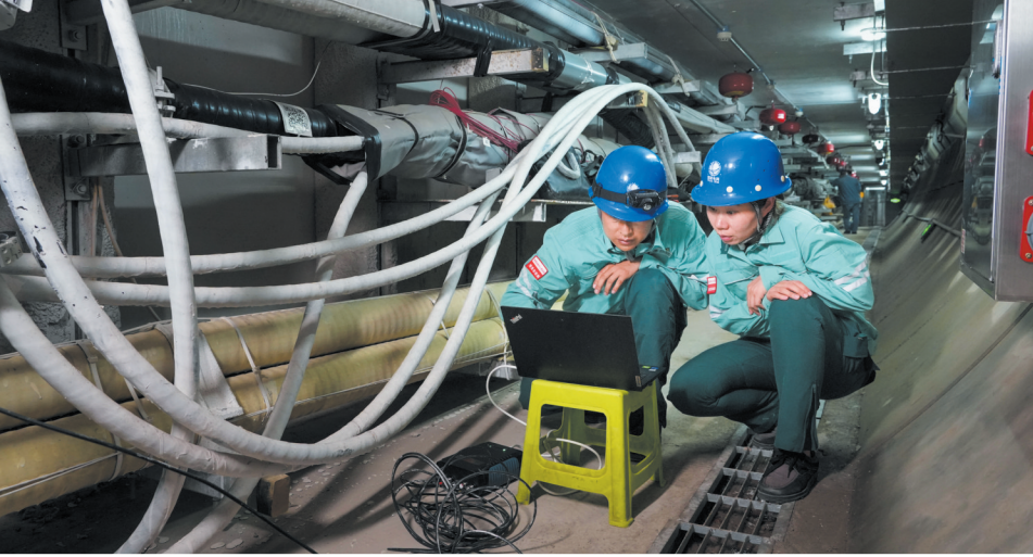
日前,邯鄯供电公司工作人员对110千伏南湖站开展检修预试工作,标志着邯鄯电网今年秋检工作正式拉开帷幕。此次秋检工作紧扣安全生产主线,重点开展主变、母线、开关及刀闸的检修试验与保护校验,同时对组合电器和开关柜进行系统治理,对无线测温及温湿度在线监测装置进行加装和检测,推动设备运维智能化升级。 魏琦 摄
