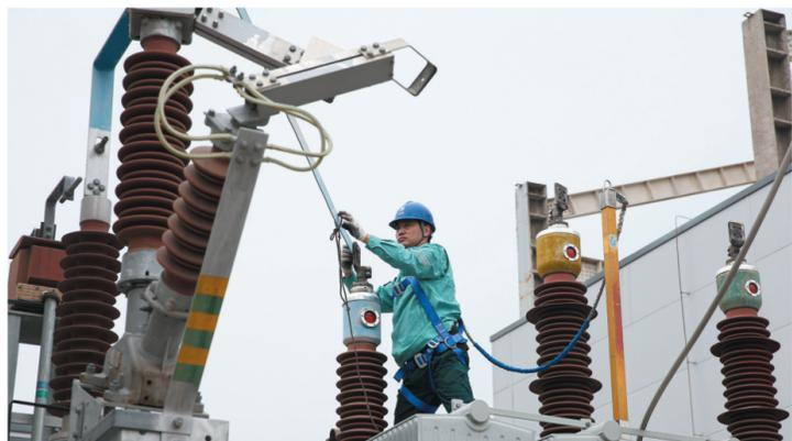
8月27日,石家庄电网秋季检修正式启动。此次秋检,石家庄供电公司积极推行“规模化+集中检修”作业模式,应用AI成票系统、北斗定位、无人机机巢等科技手段,提升检修作业效率和作业安全水平。图为在110千伏东变电站秋检现场,检修人员正在对主变开展年检试验工作。康伟 摄
