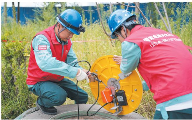
井盖。电缆运检中心工作人员为电缆接头井安装智能井盖。李方方 摄
