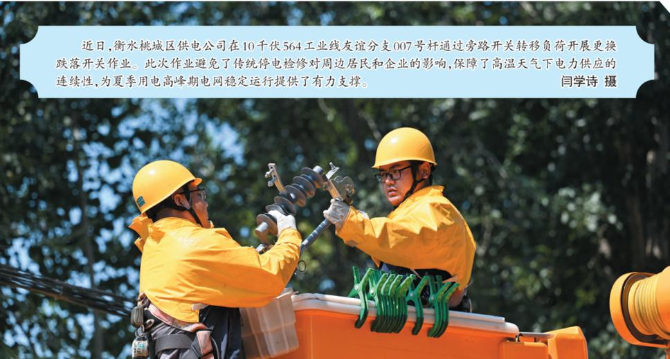
近日,衡水桃城区供电公司在10千伏564工业线友谊分支007号杆通过旁路开关转移负荷开展更换跌落开关作业。此次作业避免了传统停电检修对周边居民和企业的影响,保障了高温天气下电力供应的连续性,为夏季用电高峰期电网稳定运行提供了有力支撑。闫学诗 摄
