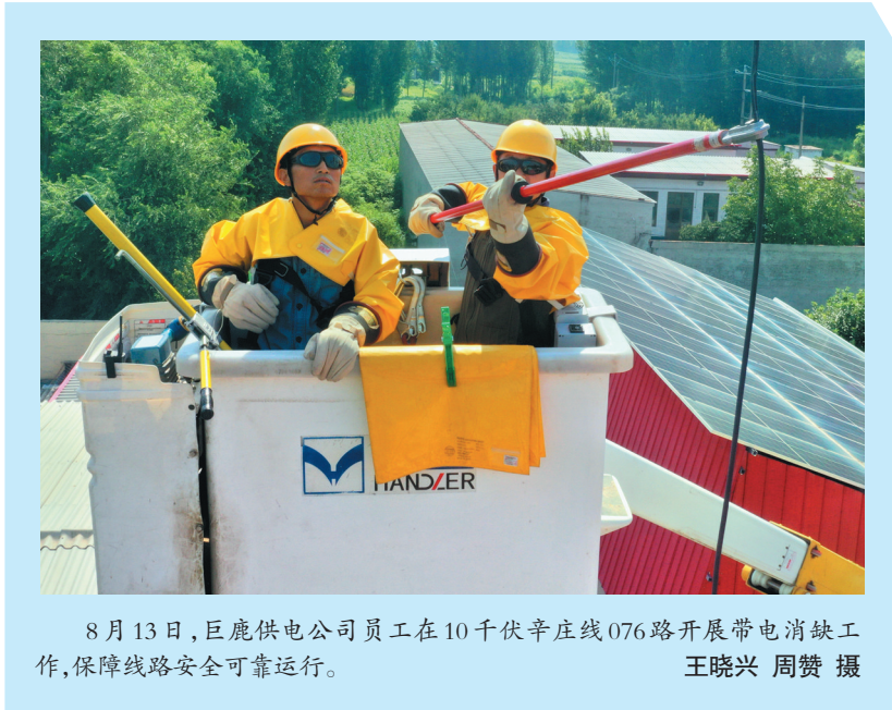
8月13日,巨鹿供电公司员工在10千伏辛庄线076路开展带电消缺工作,保障线路安全可靠运行。 王晓兴 周赞 摄
