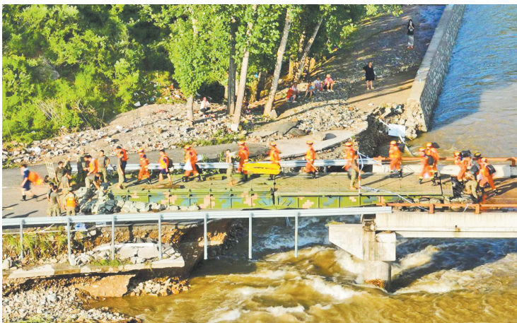
救援队正在通过修补后的滦平县王北沟门桥。
