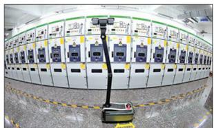
近日,秦皇岛港股份有限公司第六港务分公司自主完成三号变电所无人值守技术改造工作。这些巡检机器人能够精准采集电力设备的温度、电流、电压等关键运行数据,利用图像识别和数据算法及时发现故障隐患,并生成专项巡检报告。曹建雄 摄
