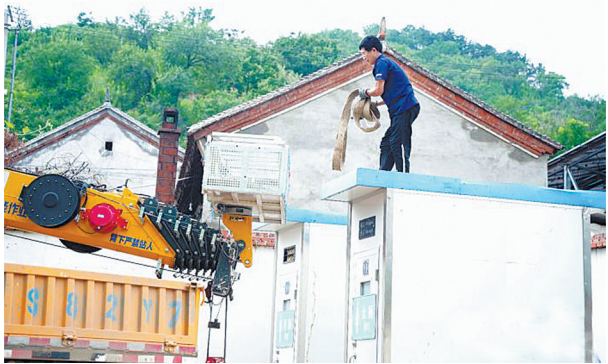
县委组织部派出工作人员正在安装临时卫生间。
