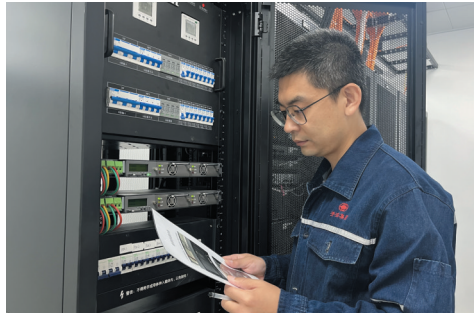
开滦集团唐山矿业公司坚持“巡检+防范”原则,开展“地毯式”隐患排查,对模块化机房湿度监测和动力机房防雷装置实施动态巡检维护,增加巡检频次,争取隐患早发现、早消除,确保通讯系统畅通。图为技术人员在检查48V变电柜防漏开关使用情况。杨璐莹 摄
