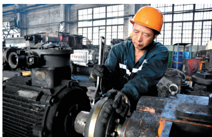
7月28日,冀中股份郭二庄矿职工在检修水泵。进入主汛期后,该矿强化排水设施检查维护,保障排水能力达到要求,提高矿井防灾减灾能力,确保安全度汛。程矿生 曹丽飞 摄
