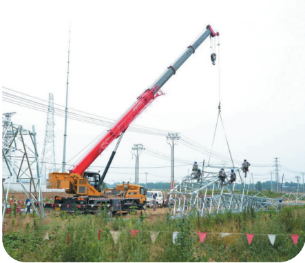
灵寿三圣院110千伏输变电工程铁塔组立现场。 李月如 摄
