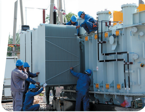
工作人员在110千伏鹿泉镇北变电站进行主变附件安装工作。 李月如 摄
