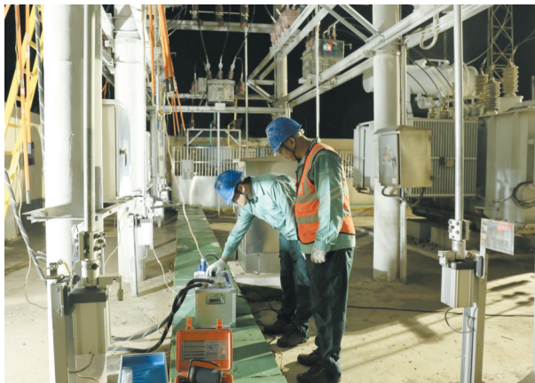
景县供电公司大力实施“电网精益运维”行动,通过智能监测、精准调度和主动服务,将传统“停电检修”升级为“带电作业”新模式。今年以来,该公司已开展配网不停电作业525次,保供电量43.2万千瓦时。 冯钊 刘慧 摄
