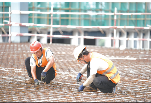
日前,在邢台经济开发区智能装备产业园(南区)邢台蕴达建设工程有限公司项目工地上,一线工人加班加点抢工期赶进度,全力推进项目建设,确保如期完工。 刘杨 李院红 摄
