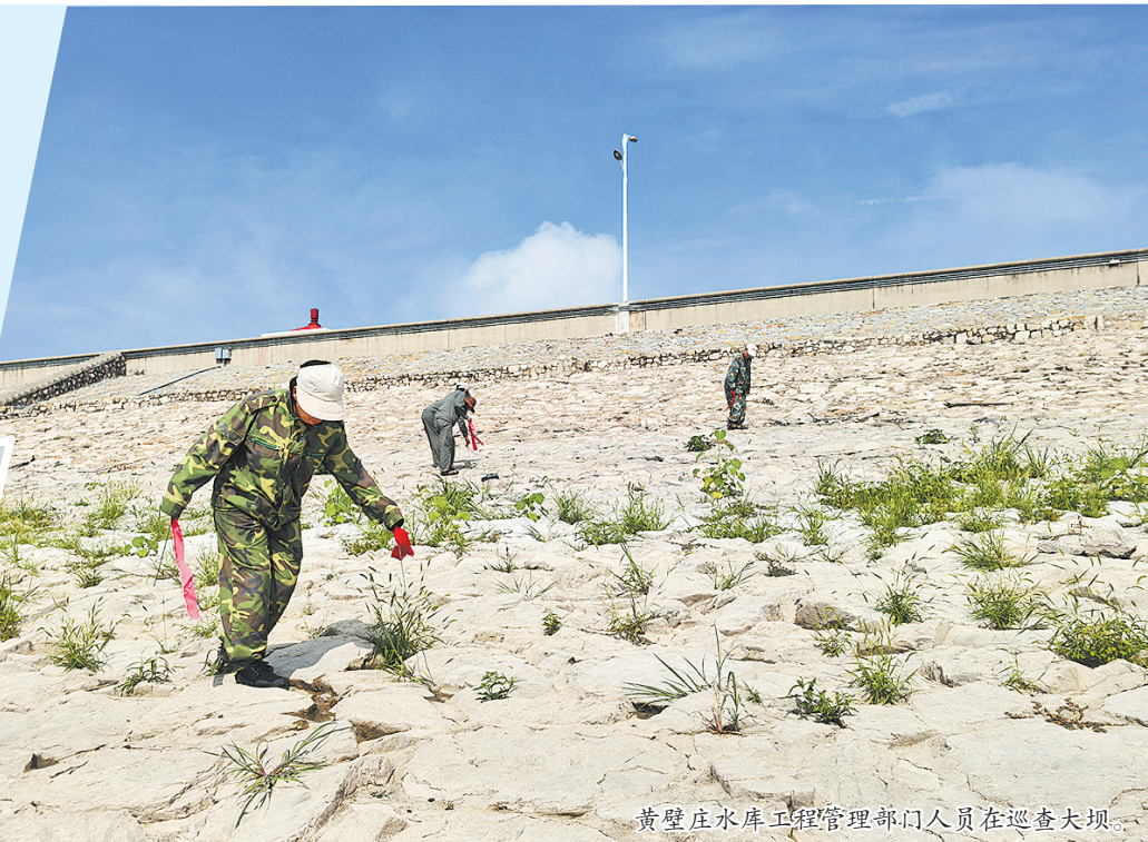
黄壁庄水库工程管理部门人员在巡查大坝。
