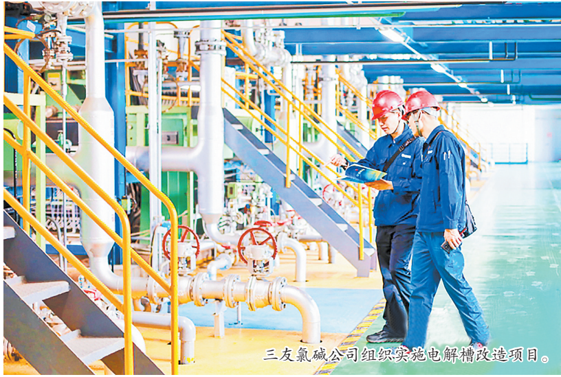
三友氯碱公司组织实施电解槽改造项目。
