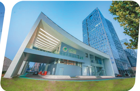
110千伏裕翔城市智慧变电站。康伟 摄
