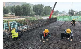
河北交投集团深化多元化产业布局，太行智慧冷链物流园项目建成后，将成为集公铁联运、冷链仓储、精深加工等多功能于一体的现代化冷链物流枢纽。图为工人在太行智慧冷链物流园集散中心卸货平台项目顶板绑扎钢筋。王金全 摄
