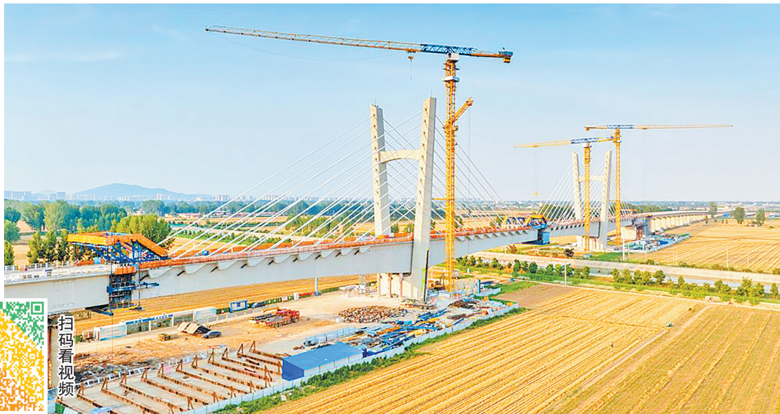
斜拉桥合龙施工作业现场。
