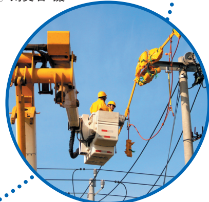
国网石家庄市栾城区供电公司工作人员对10千伏胡家寨线实施带电作业。卞策 摄
