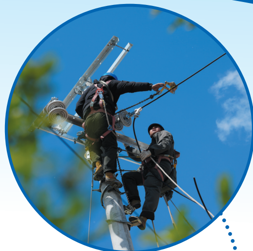
国网元氏县供电公司工作人员对10千伏852牛家庄线主干70号杆开展补强作业。刘美君 摄
