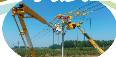
国网廊坊供电公司员工在廊坊市安次区葛渔城镇开展带电作业,为配网线路安装智能开关。
