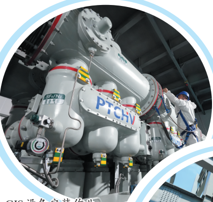
GIS设备安装作业。
