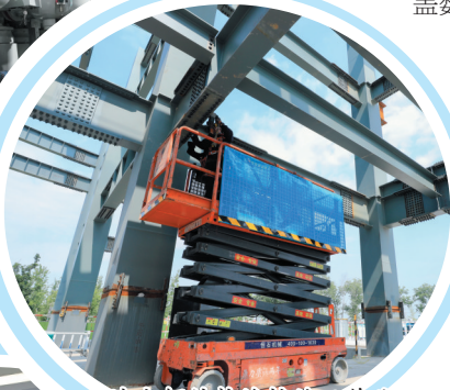
地上钢结构终拧施工作业。
