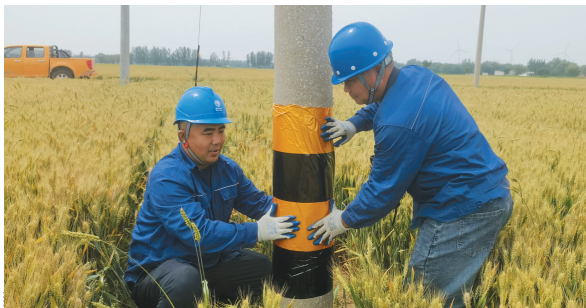
为确保电力线路安全稳定运行,防范麦田火灾风险,巨鹿供电公司张王曜供电所积极行动,通过线路巡视、安装护套、张贴反光条等多项措施,全力保障麦收期间电网安全和农户生命财产安全。 董国华 赫立园 摄
