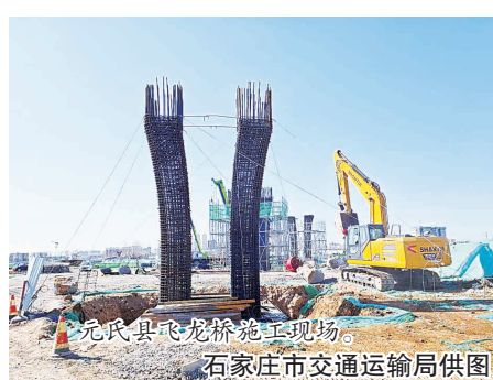
元氏县飞龙桥施工现场。 石家庄市交通运输局供图
