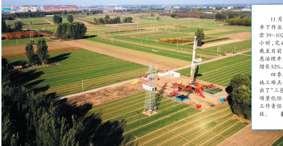
11月10日,渤海钻探井下作业公司D12554队在岔39-102井连续作业6个小时,完成通井刮削施工。截至目前,该公司共完成隐患治理井36口,比去年同期增长52%。
